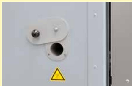
Orificio para termopar
